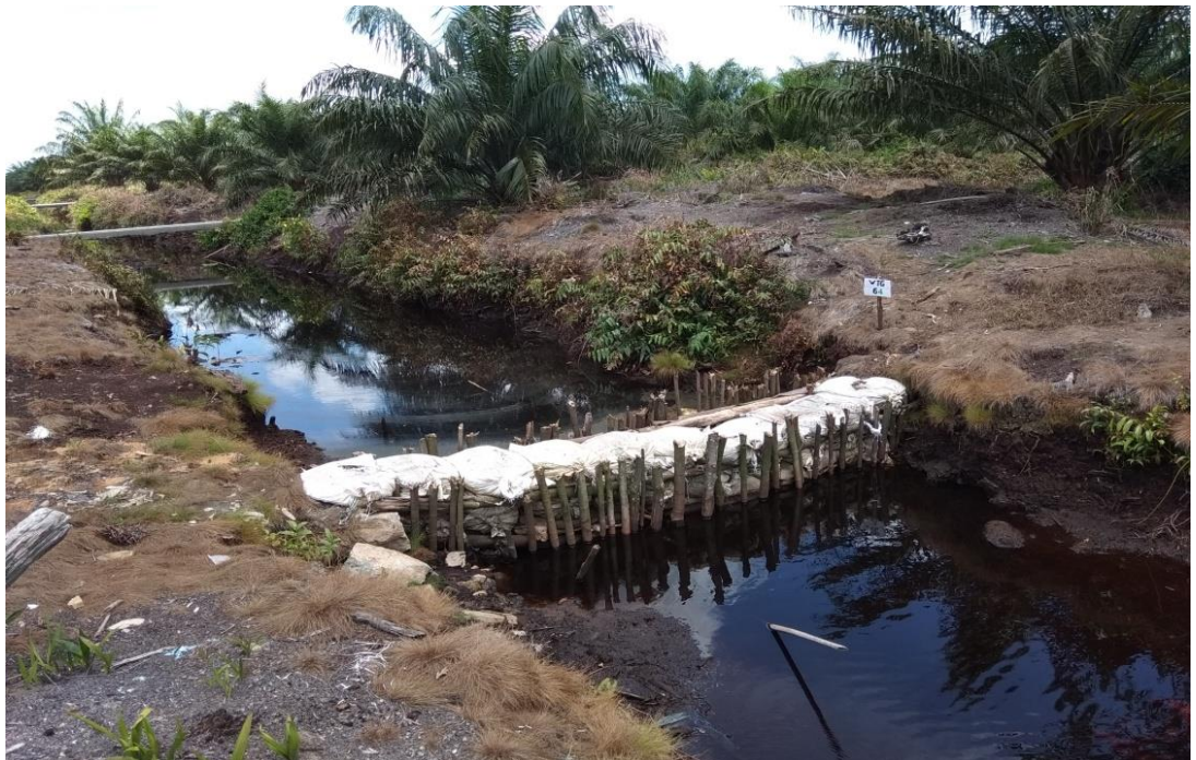
Gambar 4. Sekat Kanal di Areal Perkebunan sawit PT. Jalin Vaneo Perbatasan Desa Sungai Mata-Mata dan Desa Batu Barat
