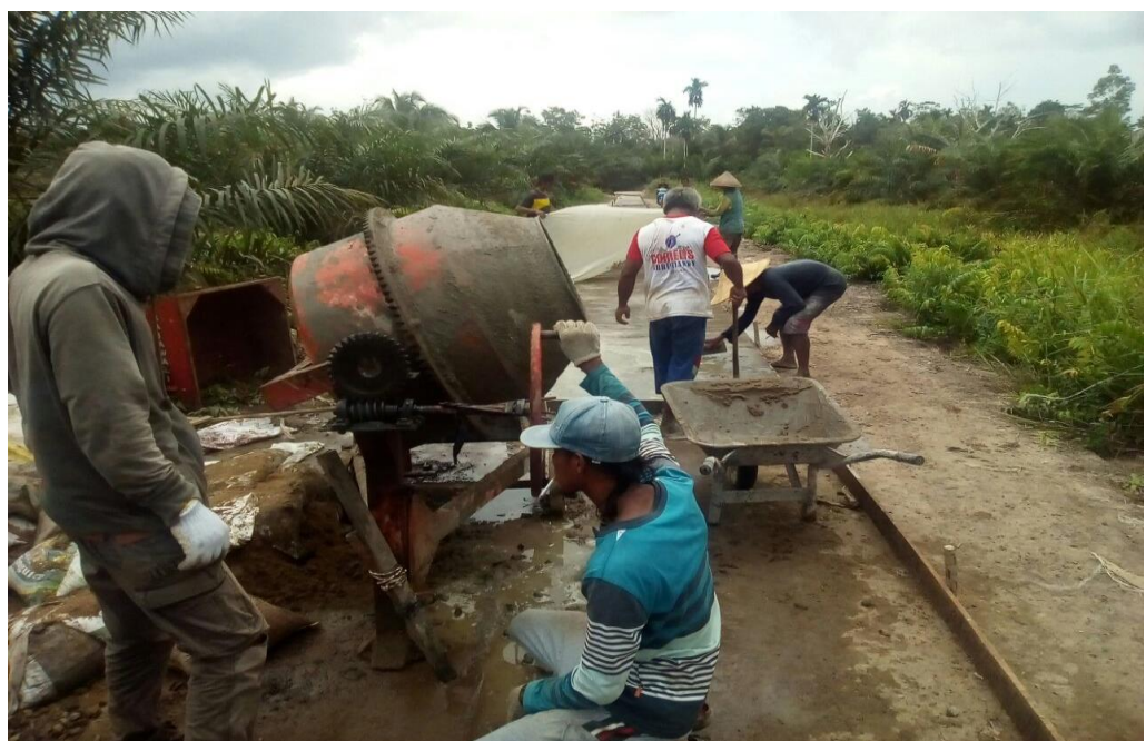
Pembuatan Jalan Rabat Beton
