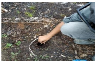
Proses Memasukkan Bambu Ke Dalam Lubang Pengeboran
